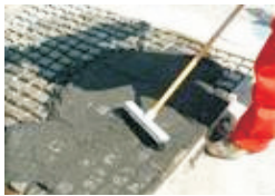
Diagonal zum Fugenverlauf einkehren
