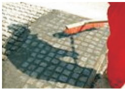
Abschließend sorgfältig Mörtelreste abkehren
