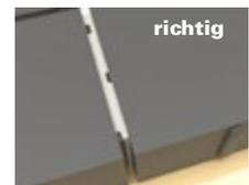
An den Seiten der Steine befindliche **Abstandhalter** sind ein Transportkantenschutz und **kein Ersatz für das vorgeschriebene Fugenmaß**. Das Einkehren der Pflasterfläche erfolgt mit gewaschenem Rheinsand oder Basaltbrechsand der Korngröße 0,02–2 mm.
