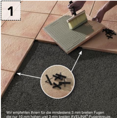
Wir empfehlen Ihnen für die mindestens 3 mm breiten Fugen die nur 10 mm hohen und 3 mm breiten AVELINA<sup>®</sup>-Fugenkreuze.
