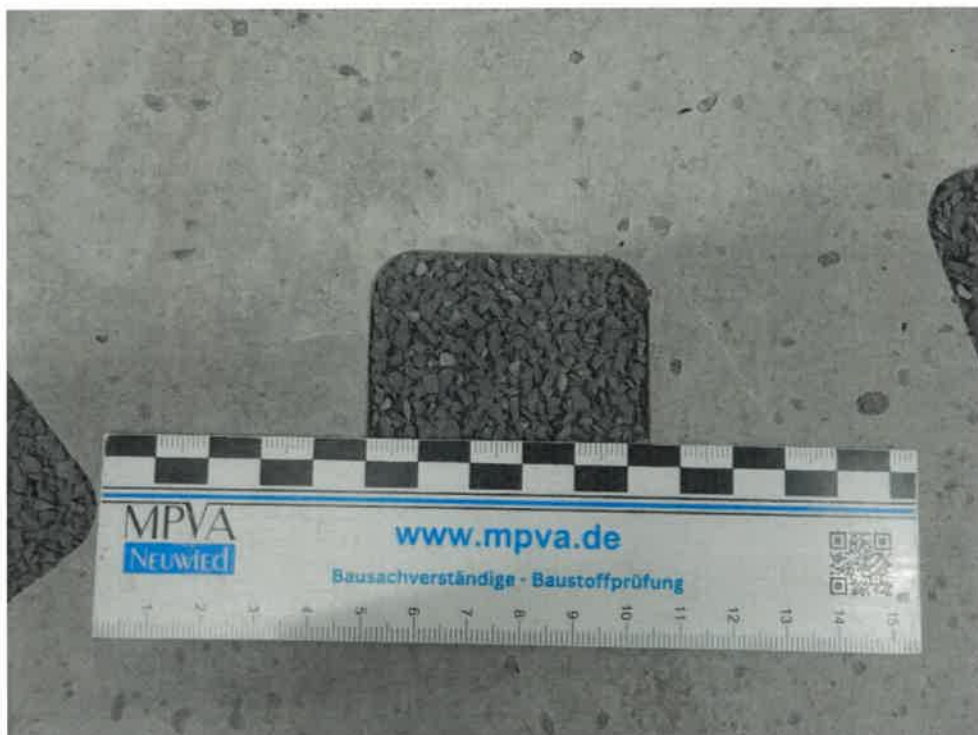
Bild 4: Ausbildung der „kleinen“ Versickerungsöffnungen mit Fugenfüllung
