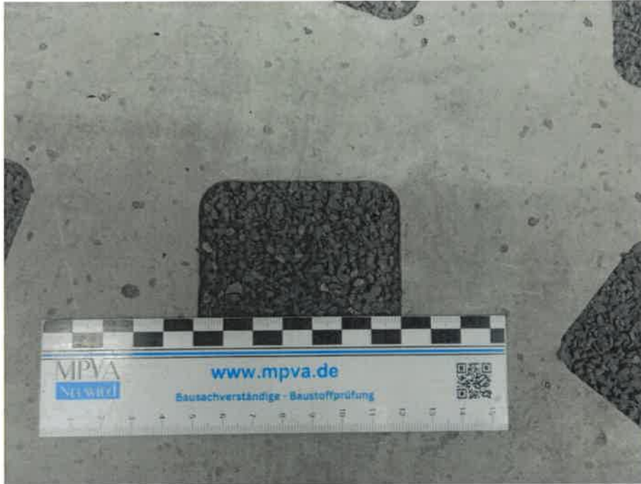
Bild 4: Ausbildung der „kleinen“ Versickerungsöffnungen mit Fugenfüllung
