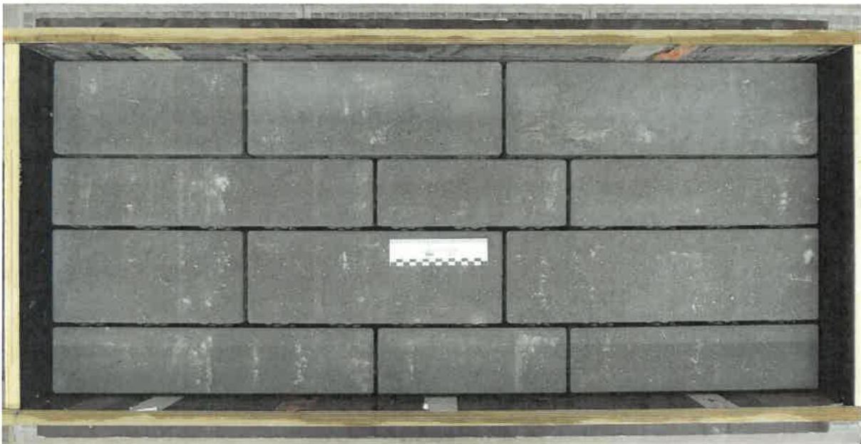
Bild 1: Verlegefläche vor der Fugenverfüllung
