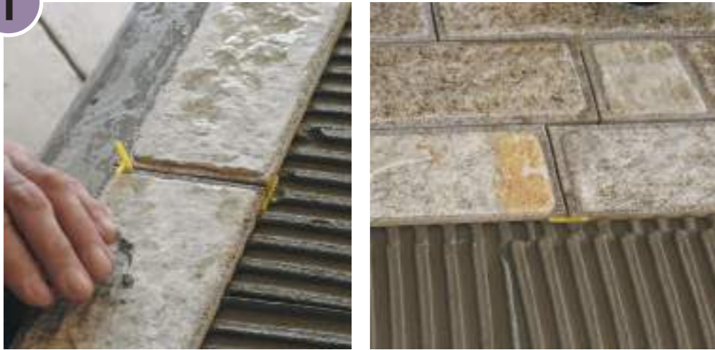
Versetzte Verlegung mit Mörtel und 2 mm Abstandshaltern
