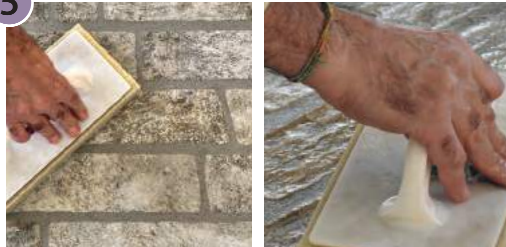
Bevor der Fugenmörtel trocken ist, beginnen Sie die Reinigungsoperation mit einer Querbewegung (um ein übermäßiges Entfernen des Mörtels zu vermeiden).
