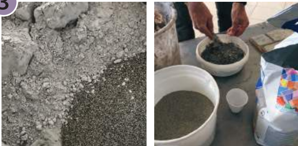
Vorbereitung des Fugenmörtels: 75 % zementhaltig + 25 % Quarzpulver
