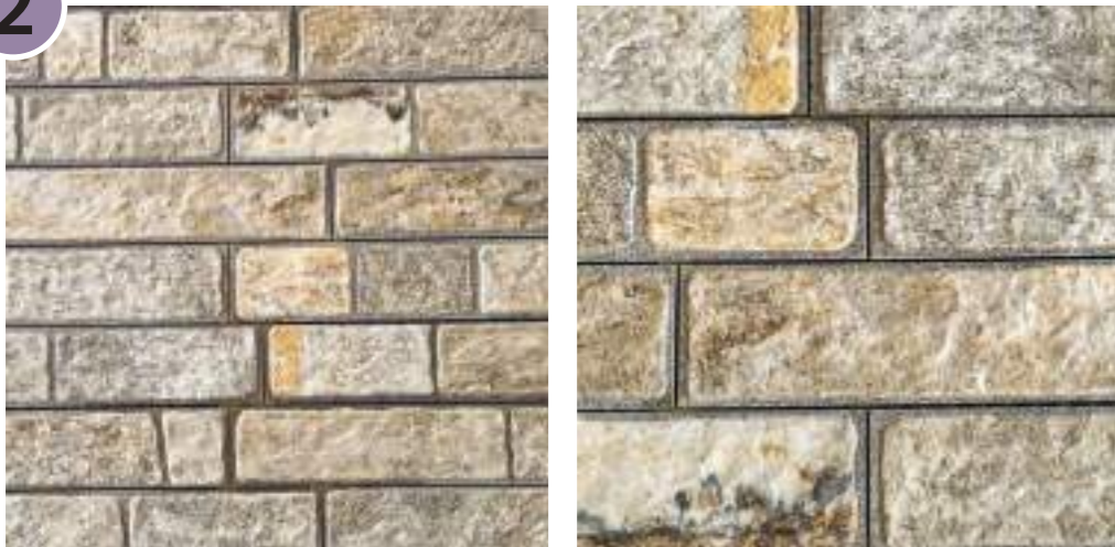
Verlegung de Materials vor dem Verfugen
