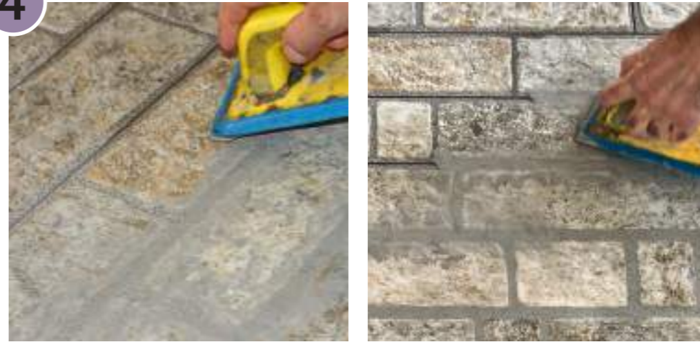
Sorgfältiges Verfugen, dabei darauf achten, die erhabenen Teile zu füllen. Die patentierte Technologie ermöglicht eine einfache Haftung des Fugenmörtels.
