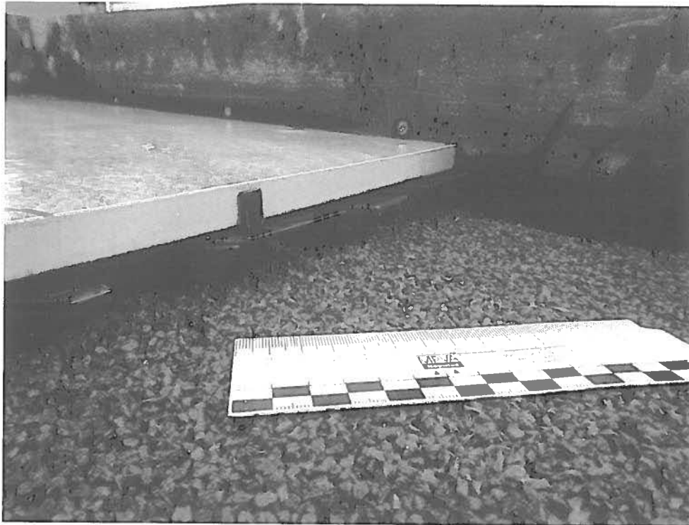
Bild 3: Verlegung auf der Splittbettung
