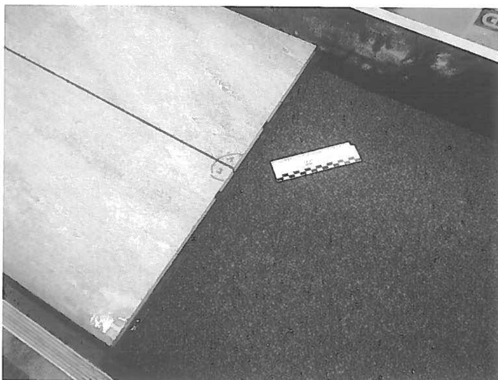
Bild 3: Verlegung auf der Splittbettung
