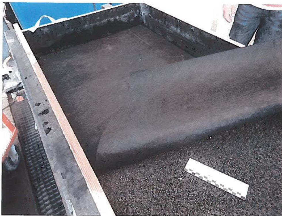
Bild 3: Verlegung auf der Splittbettung mit Kunstfaservlies
