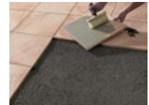
AVELINA® auf Drainagebeton
